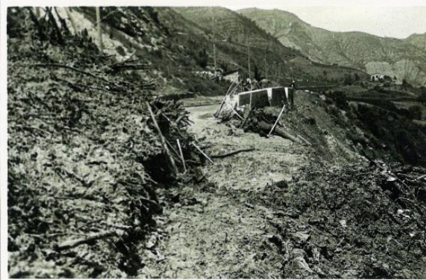
Brisighella - frana in località Pendici
