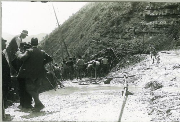
Brisighella - frana in località Pendici
