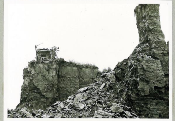
Modigliana - frana di Cà Risanello
